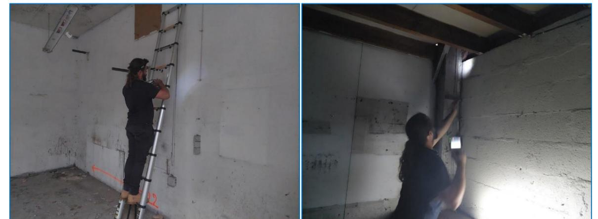
Figure 13 - Inspection des anfractuosités dans le bâti à l'aide d'une échelle, d'une lampe et d'un endoscope
